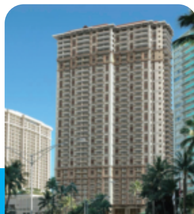
09年オープンに向けて工事が始まった「ザ・グランド・ワイキキアン」。38階建て、計331の1&2ベッドルーム・ユニットを有する、ワイキキ最大にして最もラグジュアリーなタイムシェア・リゾートとなる予定。タワー内には、ショッピングアーケード、ビーチサイドレストラン、3つのスライダー付きプールも建設される
